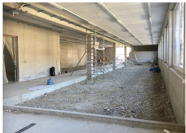
November 2020: Rohbau Halle
